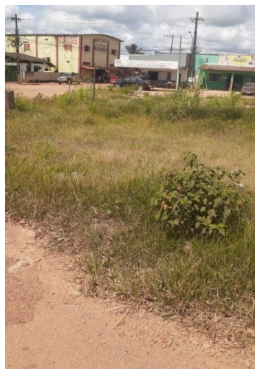
Figura 2 – canteiro da obra
